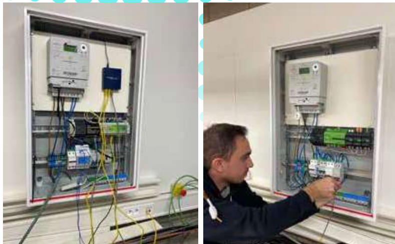
Het labo is ook uitgerust met twee elektrokasten waarin een digitale meter en een slimme sturing zijn geïntegreerd.
